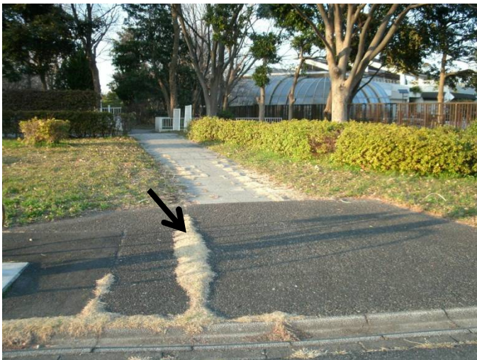
F-⑨ グリーンプラザ入口近く(1.51)
