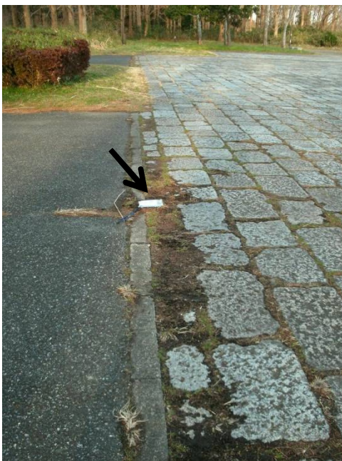
F-⑦ 記念広場入口(2.26) (土がたまっている帯状の部分は、 周辺より放射線量が高め)
